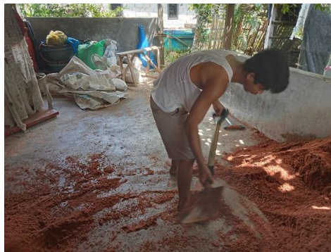
Gambar 2: Mengaduk Bahan Yang Telah Di Disaring Hingga Rata.
